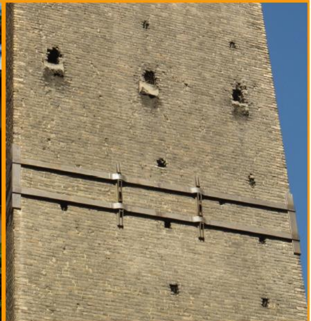
esempio di cerchiatura: Torre della Garisenda
