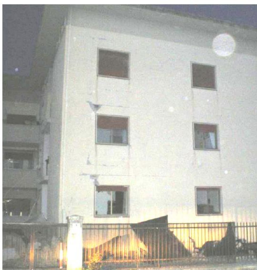
L'Aquila (Pettino): edificio con "piano soffice". Il manufatto pur conservando una discreta integrità strutturale ai piani superiori, ha subito il collasso dei pilastri al piano terra.
