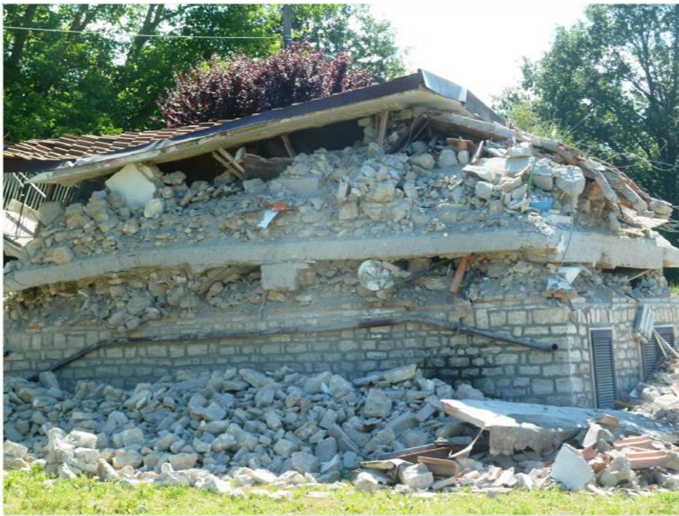
Fig. 3 - Crollo totale di un edificio in muratura con solai in CA (San Lorenzo e Flaviano, Amatrice).
