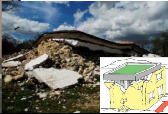
Colle di Roio (AQ) - Edificio in muratura in pietrame non squadato con malta argillosa e copertura pesante in c.a. Effetto negativo di un tetto pesante e rigido
